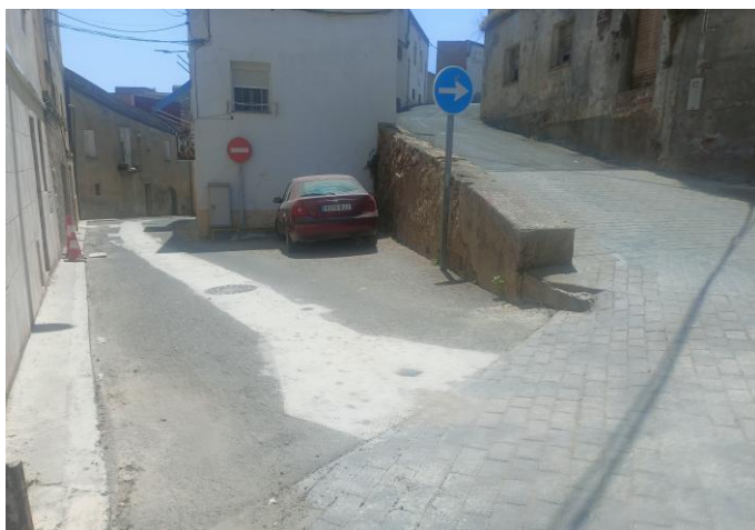
C/Calvari amb Pl. Soldevila (zona banda nord - punt final projecte reurbanització)
